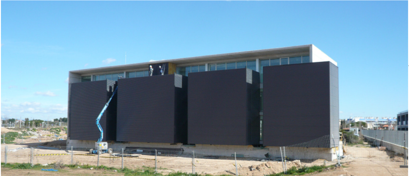
Construcció del nou edifici educacional , ubicat entre l'avinguda de Pau Casals i el carrer de Maria Castillo.
